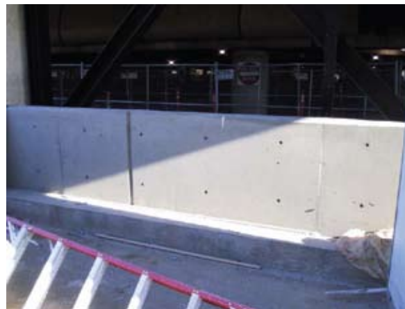
Vista de la utilización de los productos Paneltech en estructuras de cemento en la construcción del Aeropuerto Internacional SeaTac.
